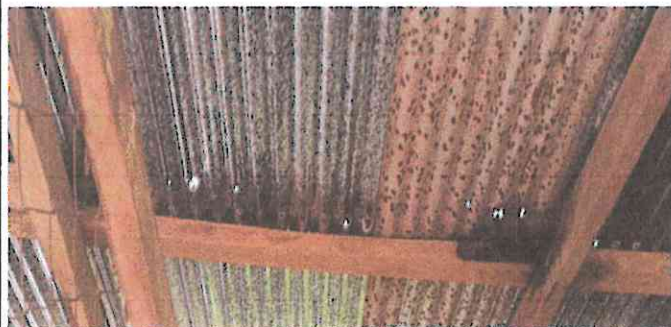
Foto 1: Sustitución de lámina (acanalada oduralita) por lámina troquelada) (Salón de usos Múltiples) El cambio de lámina se debe a que esta deteriorada y epoca de lluvia se moja todo.
