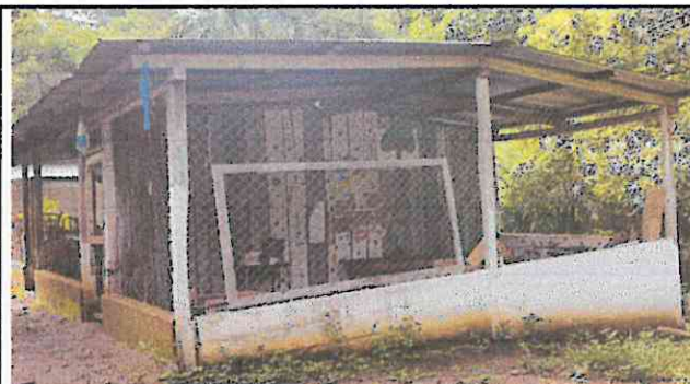
Foto 6: REPARACIÓN DE MUROS DE CONTENCIÓN (refuerzo de columnas, soleras intermedias) Sustitución de las columnas de madera a columnas de cemento para que su estructura sea más segura.
