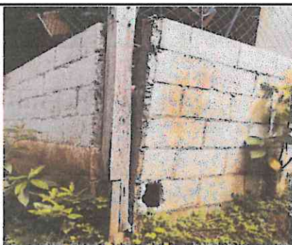
Foto 5: REPARACIÓN DE MUROS DE CONTENCIÓN (refuerzo de columnas, soleras intermedias) para que tenga mas estabilidad y soporte.
