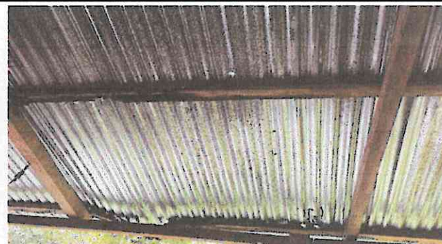
Foto 2: Sustitución de estructura de soporte por (madera o metal) (Salón de usos Múltiples) El cambio de la estructura, es por que esta quebrada ya que debido a las lluvias se ha deteriorado.
